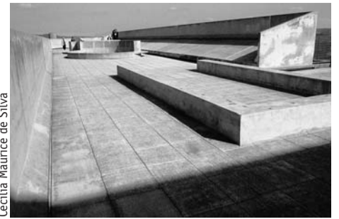
Firminy : toiture de l'Unité d'habitation de Le Corbusier
